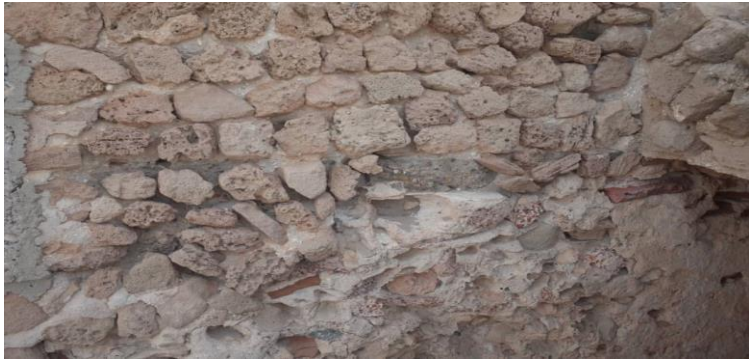
شكل رقم 8 يوضح تفتت الملاط الجيري في مبني حمامات الصيد من تصوير
