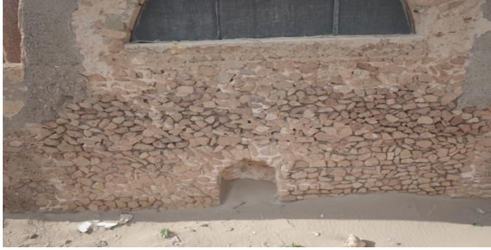
شكل رقم 14 تأثير الأمطار الحمضية في الجهة الشمالية في مبني حمامات الصيد
