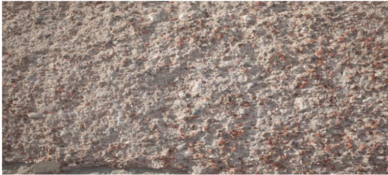
شكل رقم 4 يوضح الملاط المستخدم في بناء حمامات الصيد من تصوير الباحث
