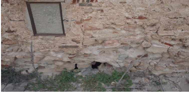
شكل رقم 9 يوضح تفتت الملاط الجيري في مبني حمامات الصيد من تصوير
